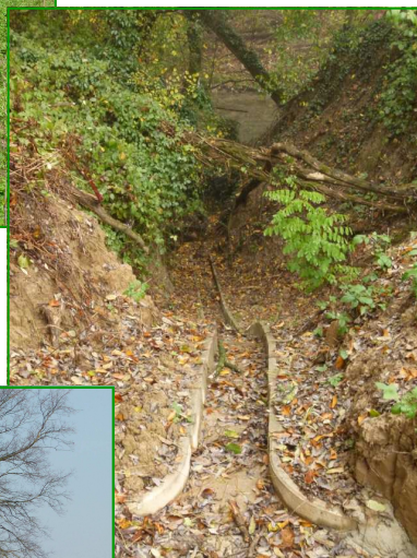
Canalina in embrici per controllare le acque piovane
