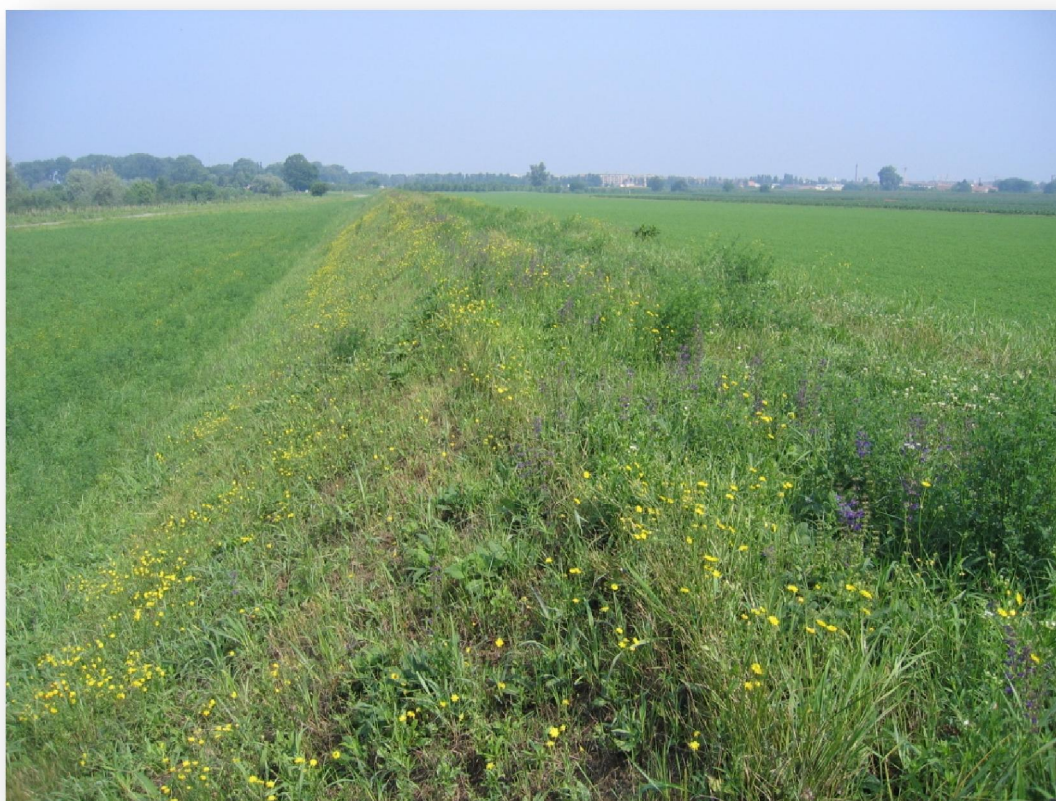
Foto 8 – Prati permanenti lungo le strutture arginali
