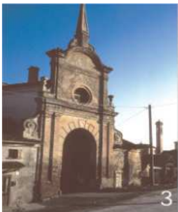
3. Accesso monumentale di una cascina cremonese a Solarolo Monasterolo.
