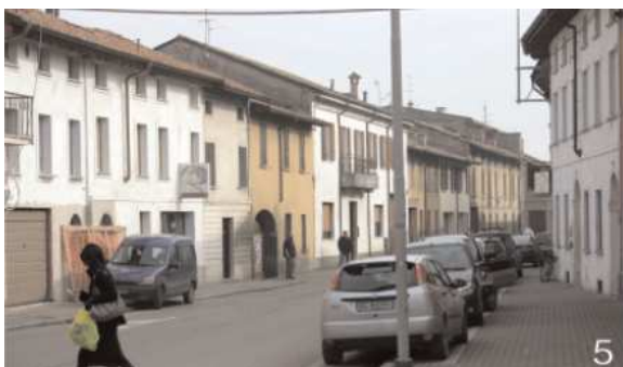
5. Esempio di corpi residenziali a schiera lungo la via d'accesso a Castelleone.
