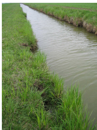
Erosione: diversi gradi di erosione della riva
