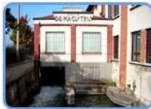
La centrale del Treacù
