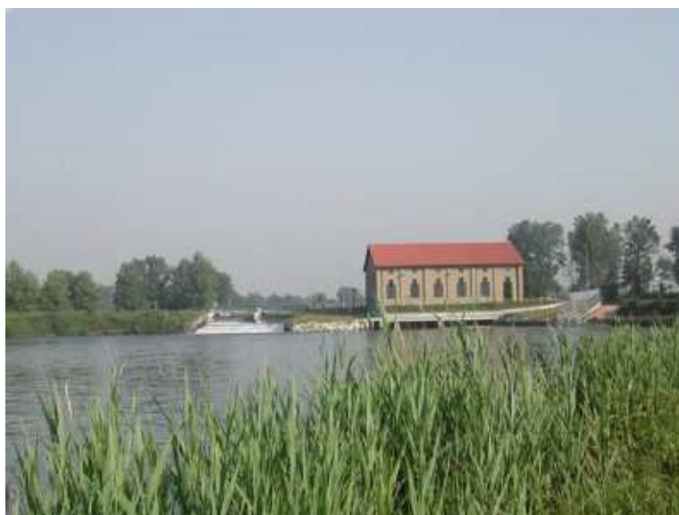
La centrale della Bolenzana
