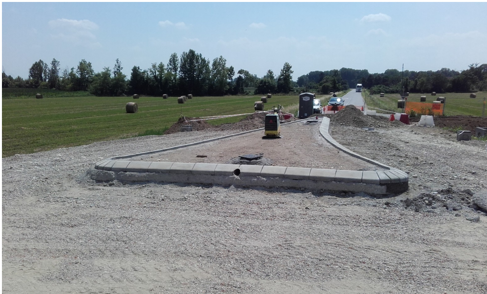
realizzazione cordoli spartitraffico
