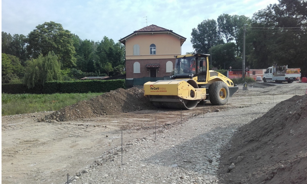
realizzazione corpo rilevato stradale
