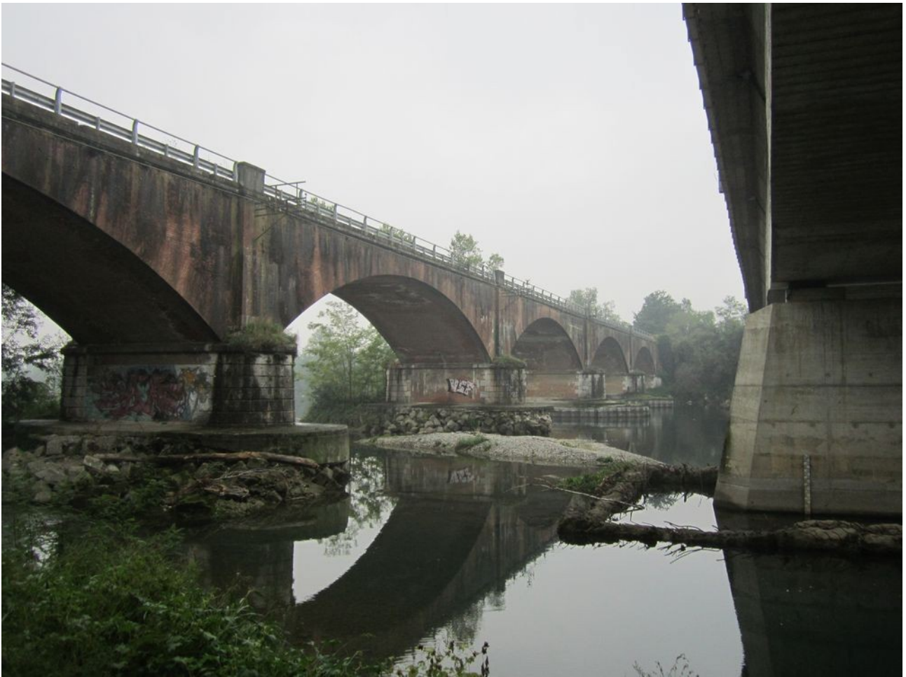
situazione attuale tra il ponte stradale della SP ex SS 415 e il ponte Asburgico
