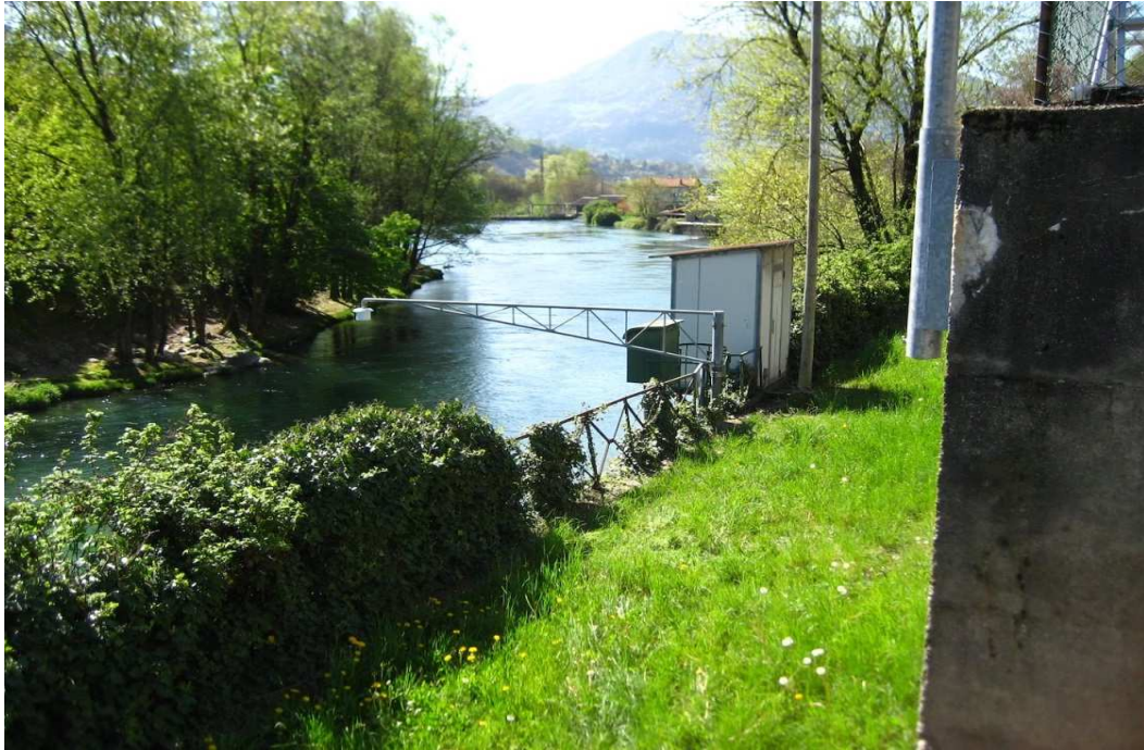
(foto n. 09 Stazione Idrometrica di Ponte Cene)
