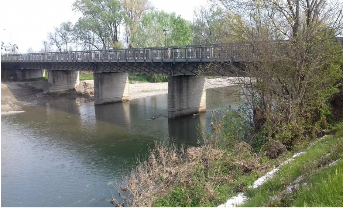
(foto n. 15 ponte S.P. n.12)
