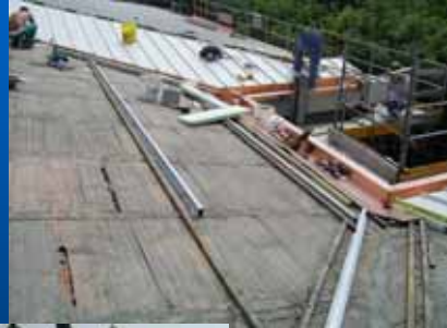
FIG. 3- FIG. 4: falda sulla quale è stato posizionato il generatore fotovoltaico da 3,15 kWp; i binari di supporto dei pannelli FV
